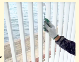
淡路島沿岸での施工風景
