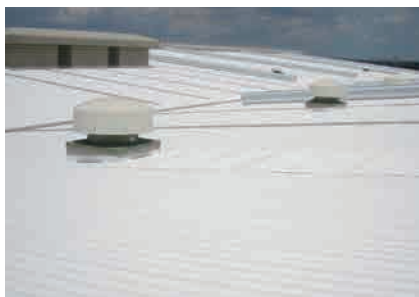
ハイドロサーモ施工事例（屋根）
